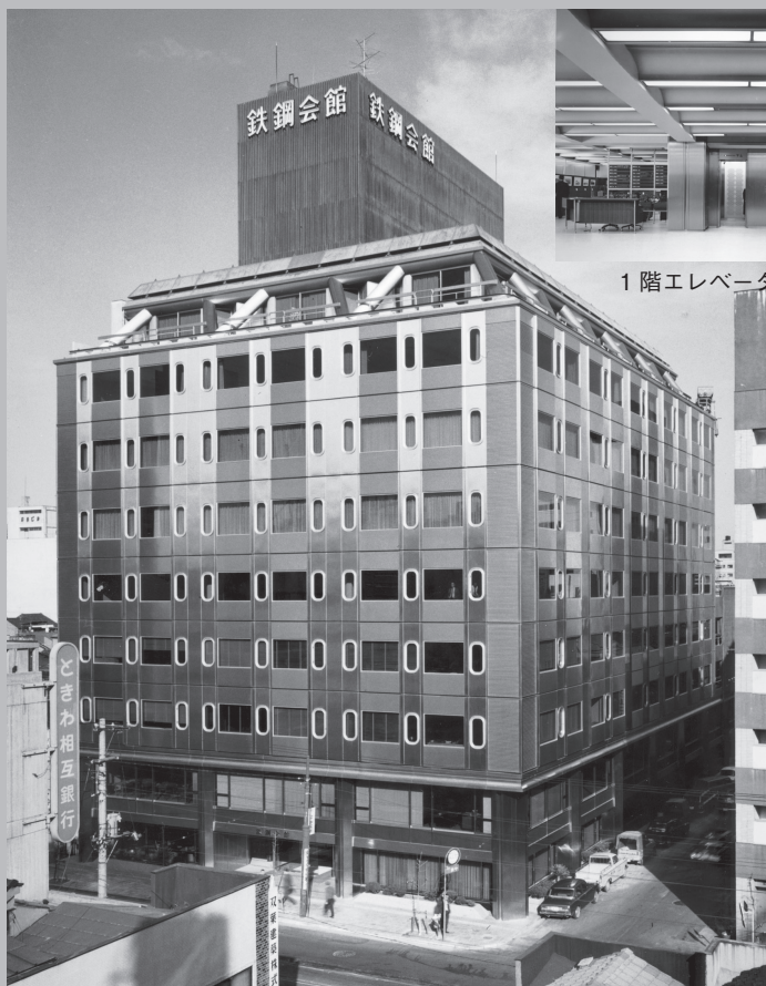
鉄鋼会館全景
