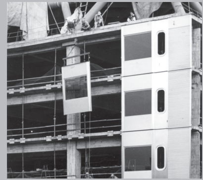
写真4 ステンレスカーテンウォール(吊込状況)
