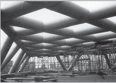
写真2 スパイラル大径鋼管で組立てられた大空間
